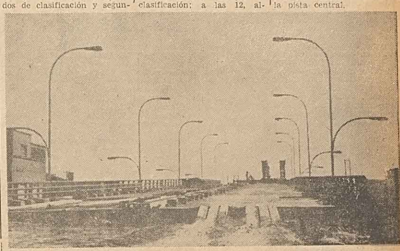
Un aspecto de los actuales trabajos en un sector del viaducto Avellaneda.
