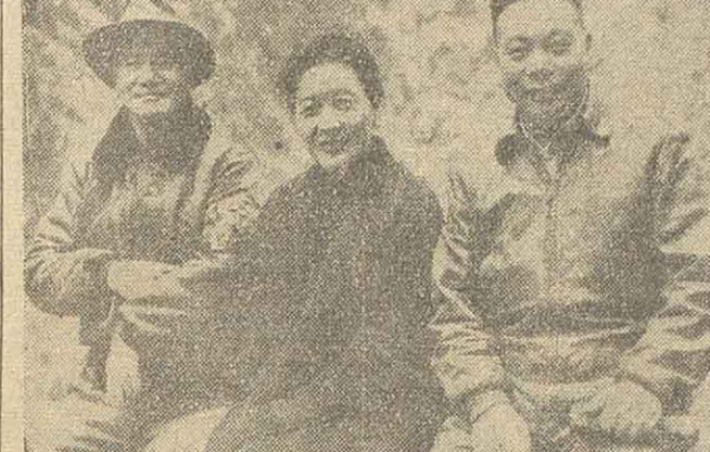
Chiang Kai Shek aparece con su esposa e hijo, durante su visita a Fouzoua, donde inspeccionó las obras de una carretera en construcción. Su hijo, el general Chiang Kuo, dirige los trabajos de construcción del citado camino.
