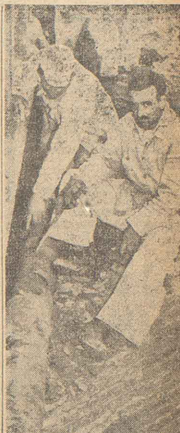
Los obreros de Yacimiento Petrolífero Fiscal, sorprendidos en plena tarea de reparación del paflofucto, en el que manes criminales colocaron una bomba, reeditando nuevamente el bárbaro atentado de meses pasados. La potencia del estallido de la máquina infernal provocó daños de cierta consideración, y el trabajo de operarios como estos, ha de permitir reanudar en breve los envíos de combustible desde la desfilera de Dock Sur.
