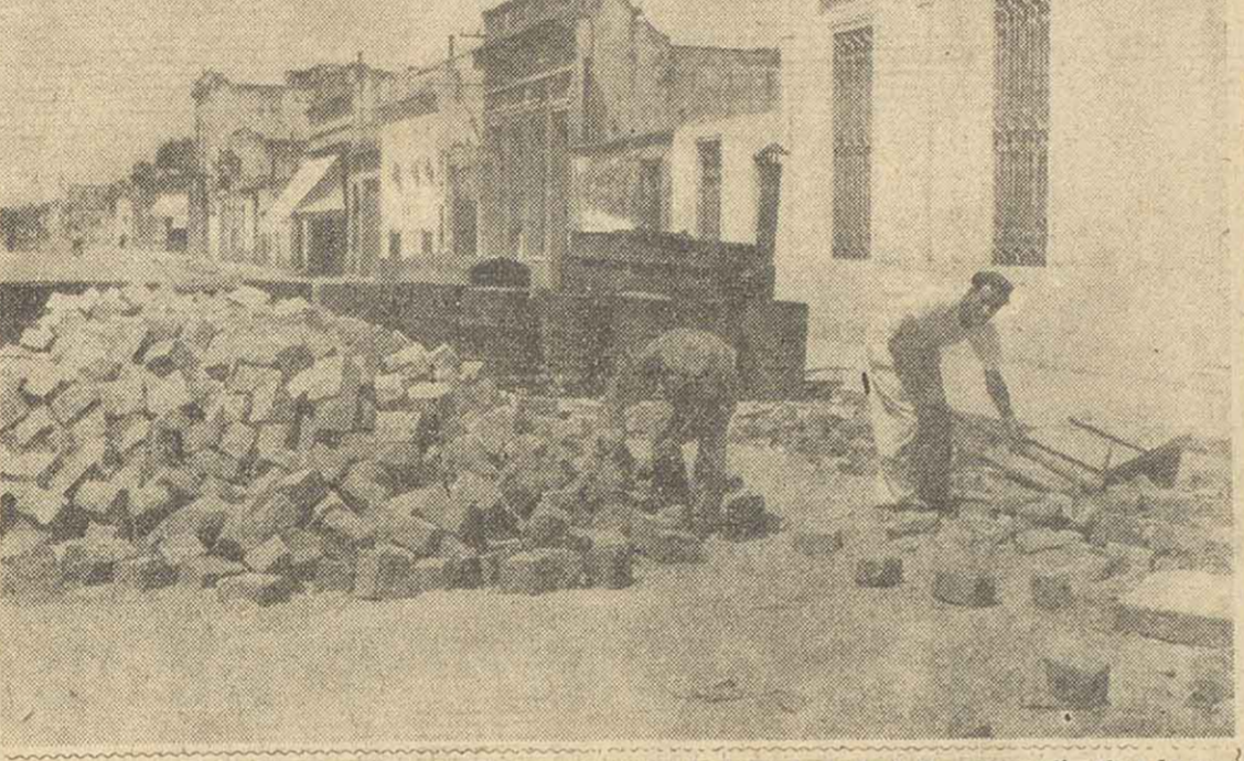
La secretaria de Obras Públicas de la Municipalidad, ha iniciado en la fecha un amplio plan de pavimentación en nuestra ciudad, disposición reamente oportuna ya que contempla una urgente necesidad urbana. En la intersección de Pasco y Corrientes, dos obreros han sido sorprendidos esta mañana, en plena tarea. (Información en la página tres)
