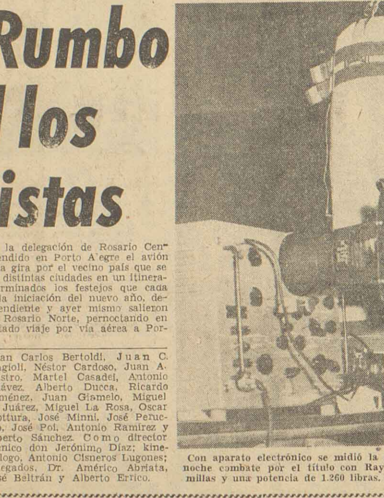
Con aparato electrónico se midió la potencia y velocidad del "punch" de Gene Fullmer, que esta noche combata con Ray "Sugar" Robinson. El osciloscopio señaló una velocidad de 30.4 millas y una potencia de 1.260 libras. Por su parte, Robinson ataca a 15.2 millas y 1.500 libras.
